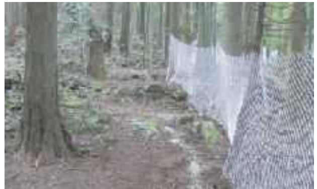
写真-2 誘導ネットの設置
