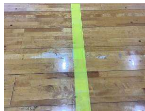
体育館フロアのテープ跡や破損個所の修繕
