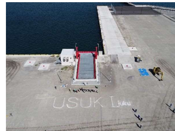
施工現場見学
