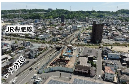
庄の原佐野線（下郡工区）整備状況
