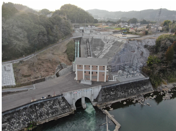
【現在の大野川発電所】
