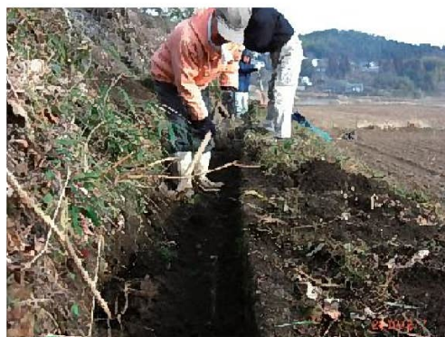
手作業による泥上げ作業
