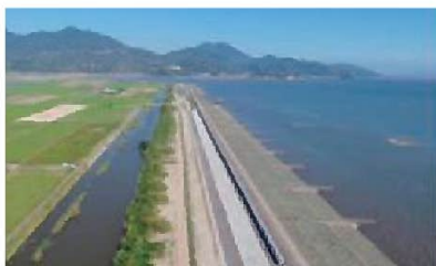
海岸整備（堤防の補強）
