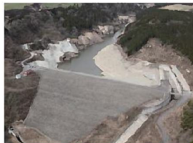
建設中の大蘇ダム
