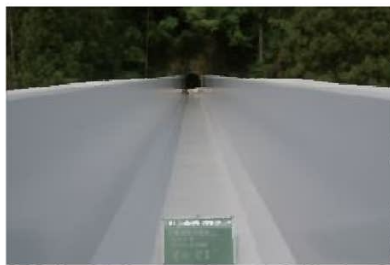
水路の長寿命化（補修・補強）
