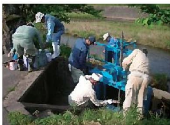
老朽化した施設の補修
