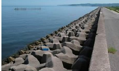
海岸整備（消波ブロック）
