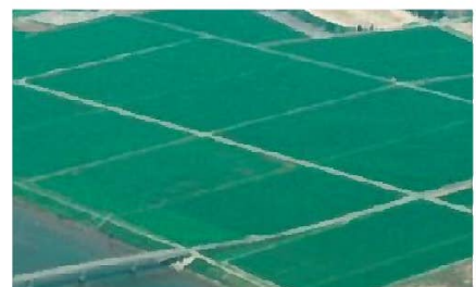
ほ場整備後の大区画水田
