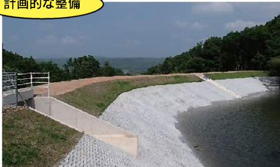
ため池の改修
