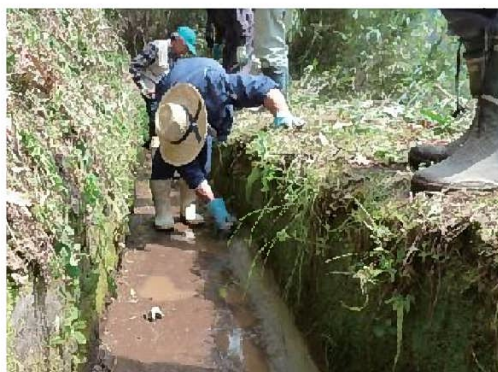
漏水防止のための目地塗り作業
