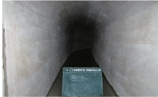
整備後の水路トンネル
