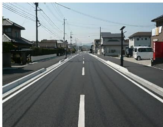
近隣地区と幹線道路とを結ぶ集散道路であり、近隣住区内の幹線としての機能を有する道路 市道（大分市）
