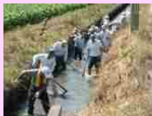
水路の泥上げ
