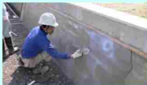
老朽化した水路壁のコーティング
