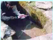
水路のひび割れ補修
