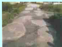
農道の窪みの補修
