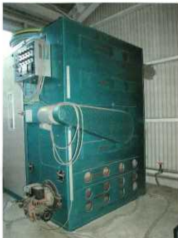
写真Ⅲ-1 吸気口側の開口状態（初期設定）：6段7列の吸気口のうち燃焼炉のある下部の2段3列を開放
