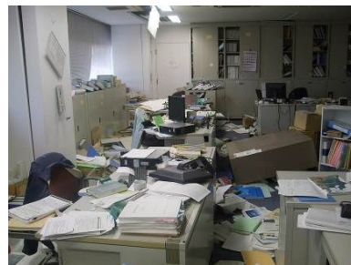
固定していなかった什器の転倒
