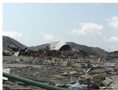
津波の被害を受けたコンビナート 消防科学総合センター災害写真データベースより
