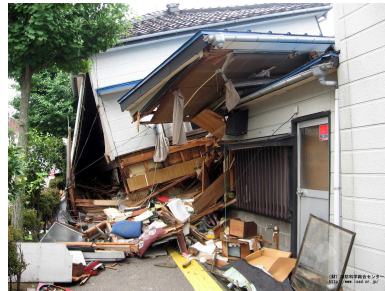
木造家屋の倒壊と路地の閉塞 消防科学総合センター災害写真データベースより
