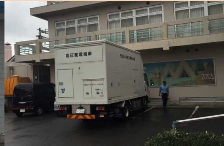
電源供給車受け入れ訓練
