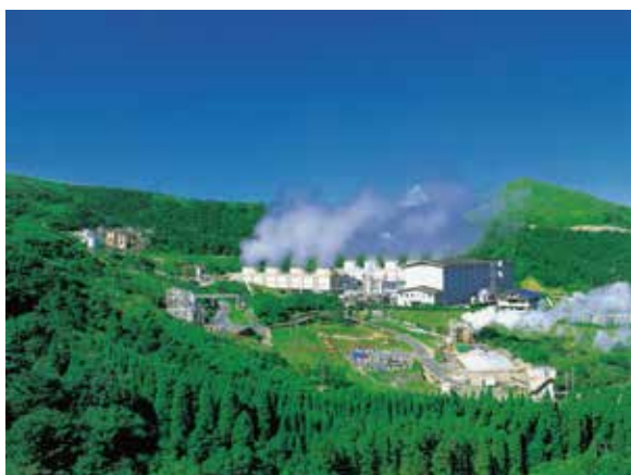
九州電力（株）八丁原発電所（九重町）
