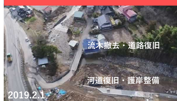
復旧状況（道路・護岸整備）
