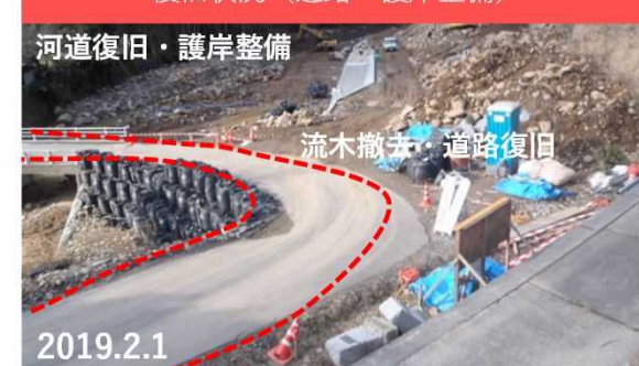
復旧状況（道路・護岸整備）
