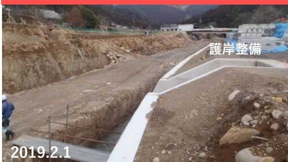
復旧状況（護岸整備）
