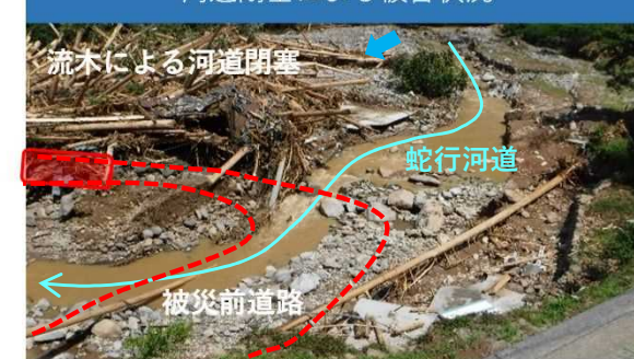
河道閉塞による被害状況
