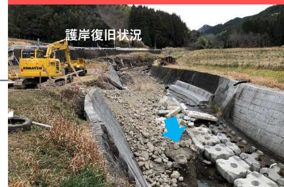
現在の状況（護岸仮復旧）
