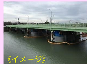
橋梁耐震化工事
