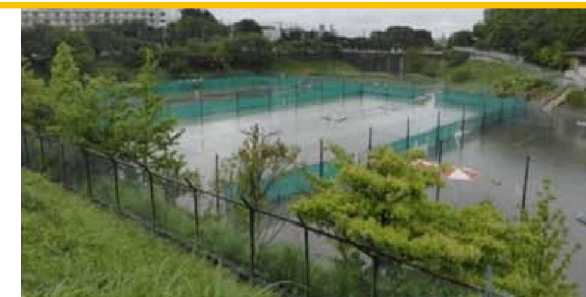
雨水調整池の整備(●●市)
