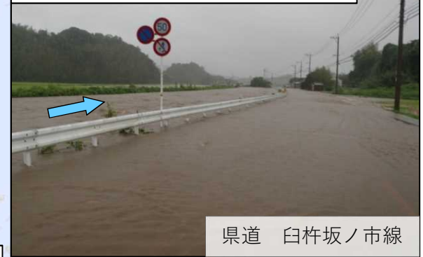
熊崎川 浸水状況 (H23.9)
