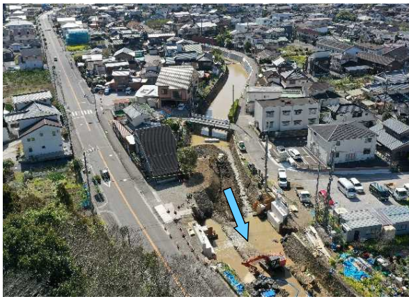
彦の内川(整備済区間)
