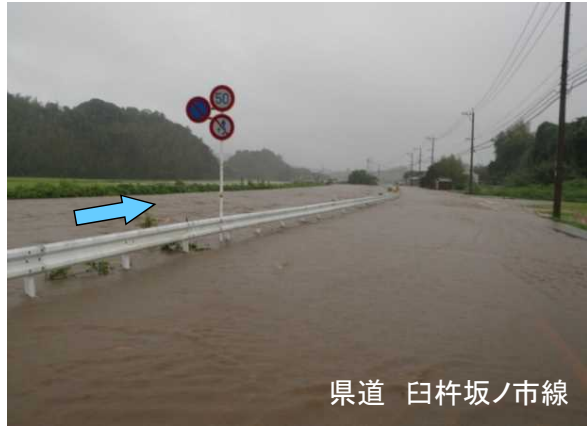
熊崎川浸水写真(H23年9月)
