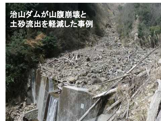
治山事業の実施による流木・土砂の流出抑制効果
