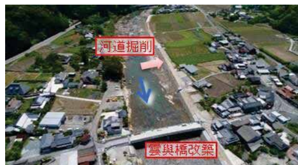
山国川改修状況
