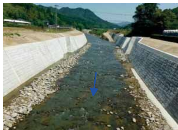
大肥川改修状況 (茶屋ノ瀬橋付近)
