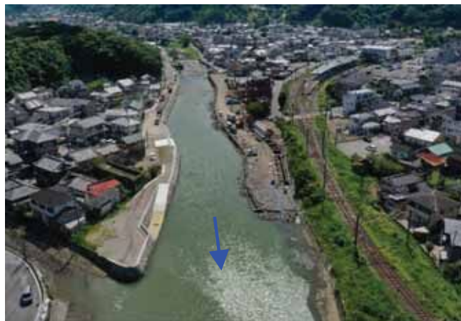
津久見川改修状況
