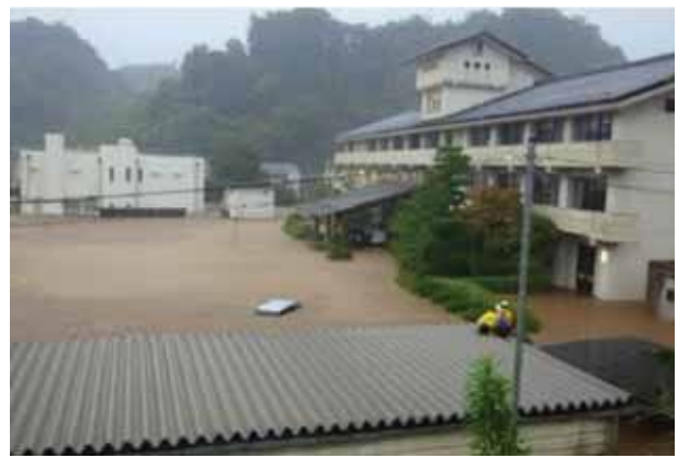
竹田総合庁舎浸水状況(竹田市大字竹田)
