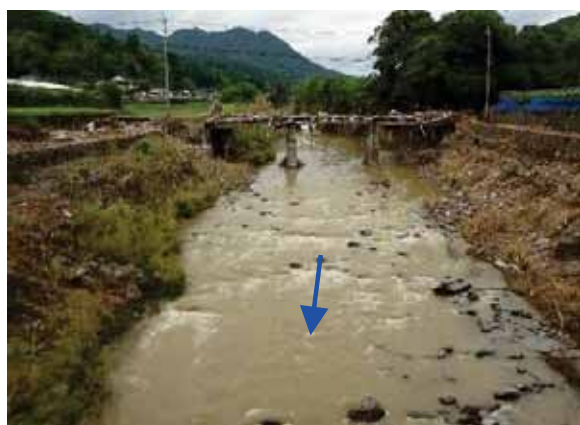
大肥川出水状況 (茶屋ノ瀬橋の溢水状況)
