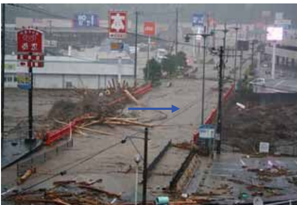
玉来川出水状況(竹田市大字玉来、桜瀬橋付近)
