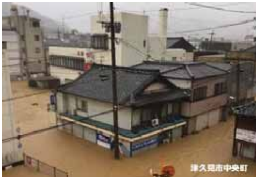
津久見川出水状況
