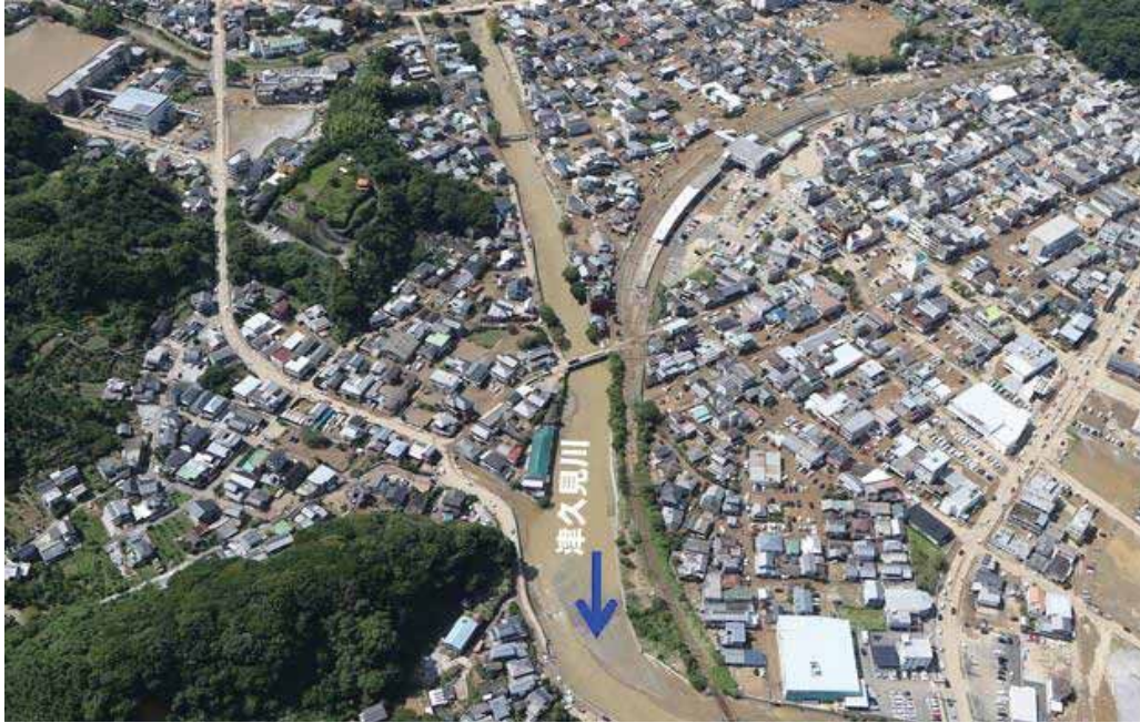
津久見川出水状況
