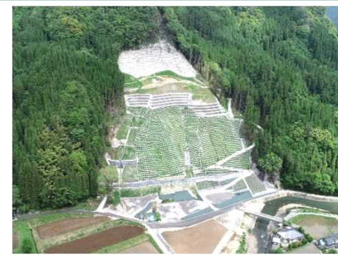
災害復旧工事
