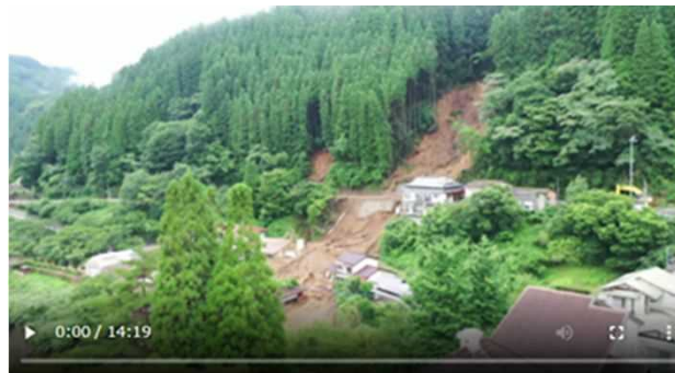
「大分県災害対応支援システム」と連携し、県・市町村等が災害時にドローン映像を共有
