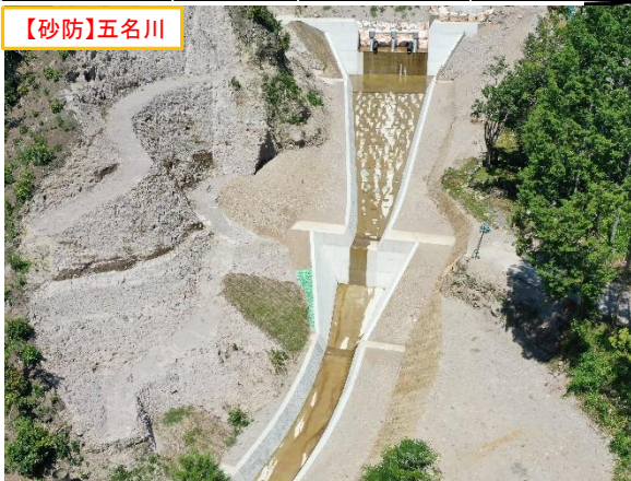
令和3年度の取組 砂防設備の整備
