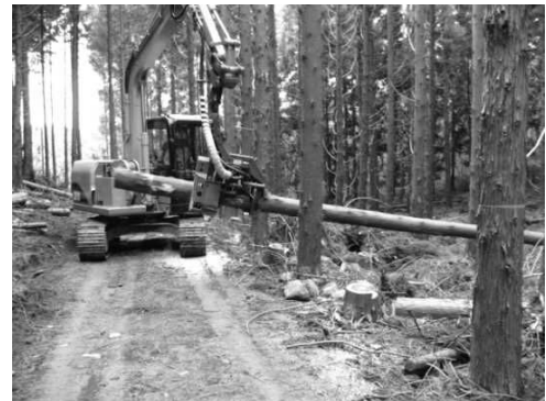
高性能林業機械による搬出間伐
