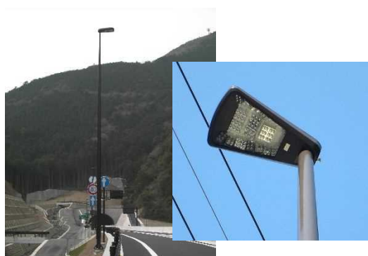
LED ライトの設置状況
