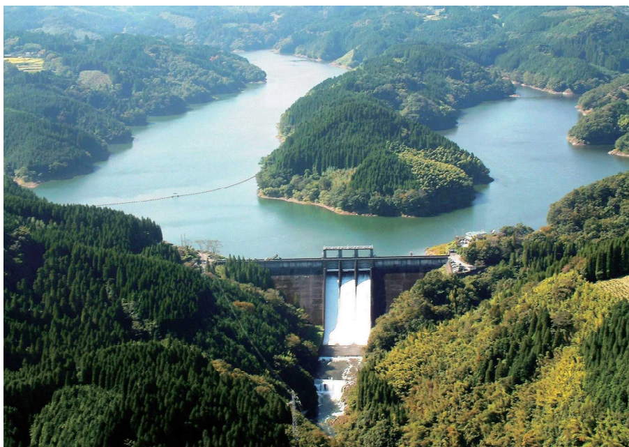
芦川ダム（左岸：竹田市、右岸：大分市）
