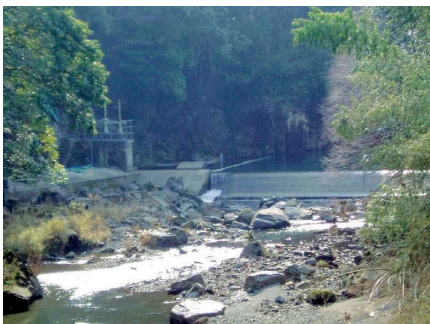
三重川取水堰
