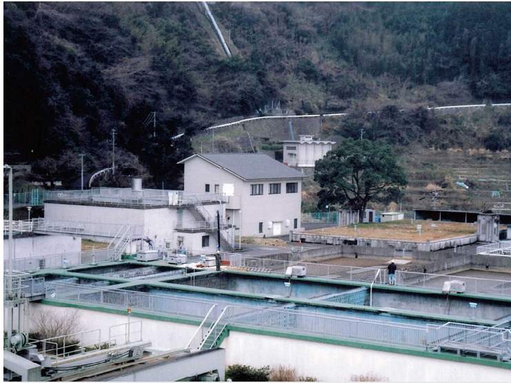
別府発電所（後方）と別府市朝見浄水場（手前）
