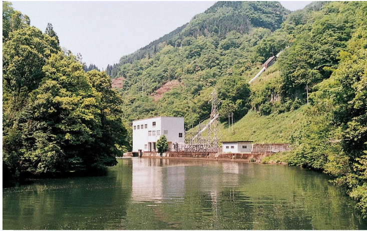
芹川第一発電所
