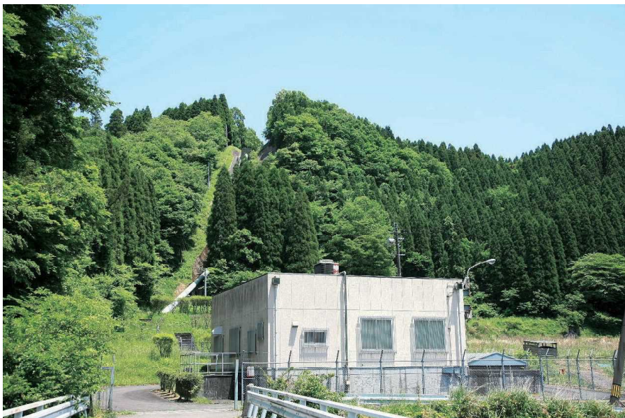
鳴子川発電所
