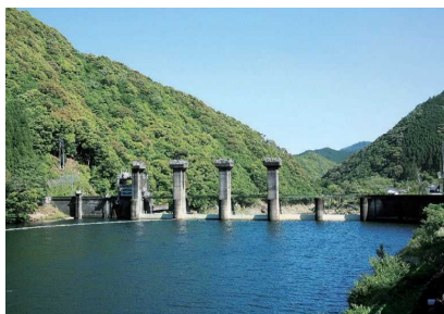
下赤逆調整池ダム
