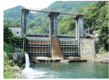
逆調整池ダム
