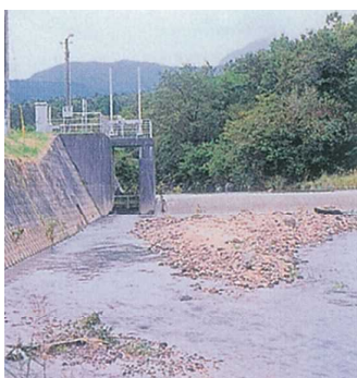
白水川取水堰
