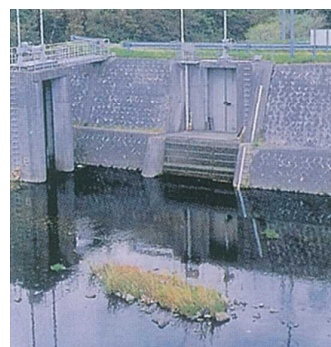
鳴子川取水堰
