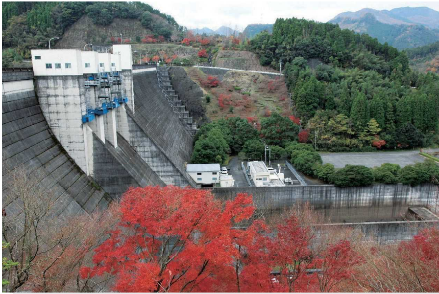
耶馬溪発電所
