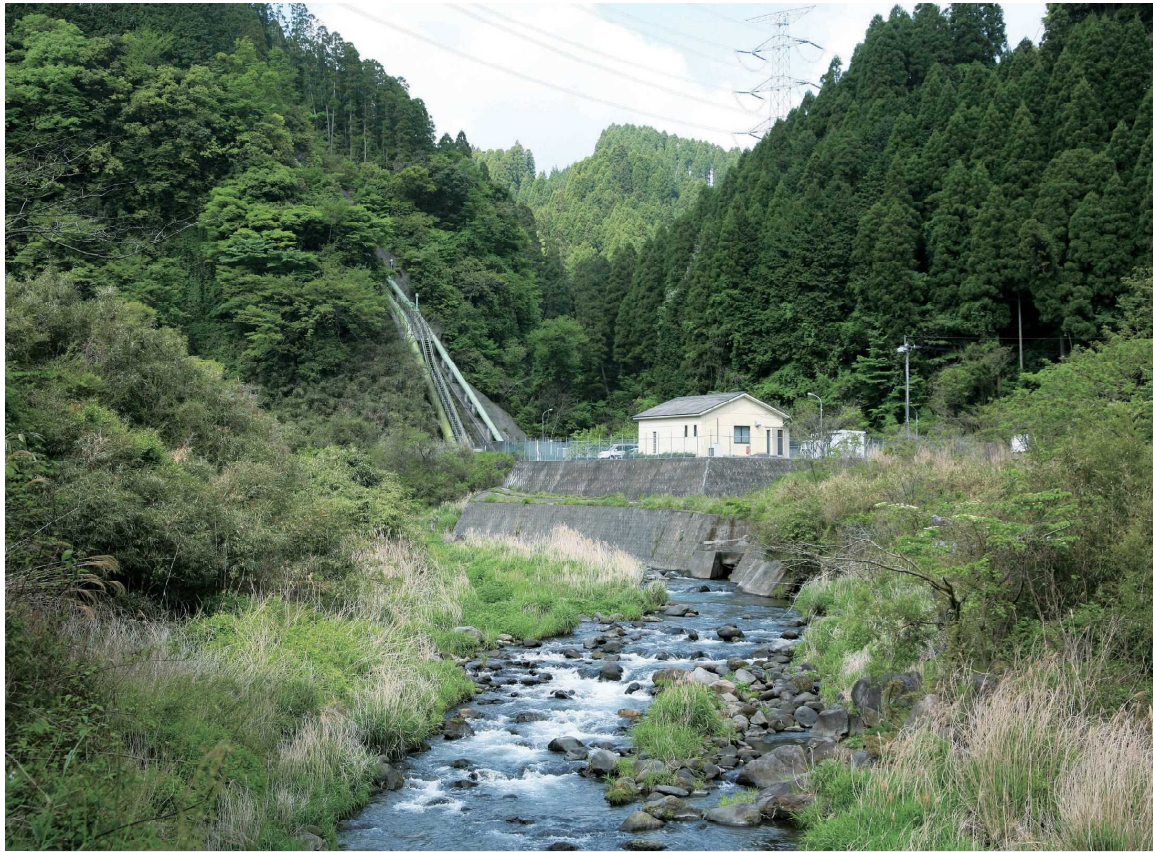
阿蘇野川発電所
