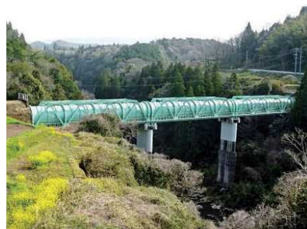
三重川水管橋
