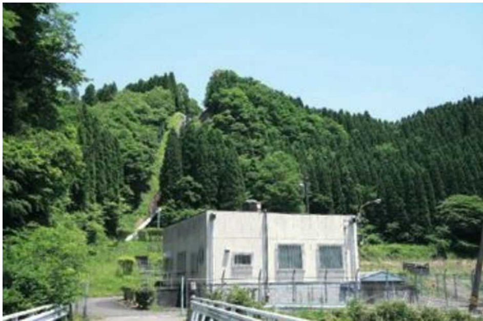
鳴子川発電所
