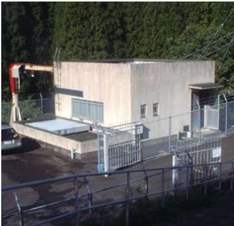
花合野川発電所
