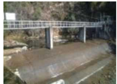
小挾間川取水堰
