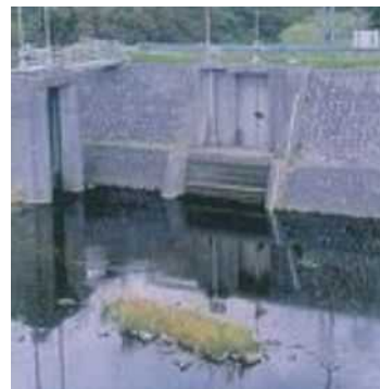
鳴子川取水堰
