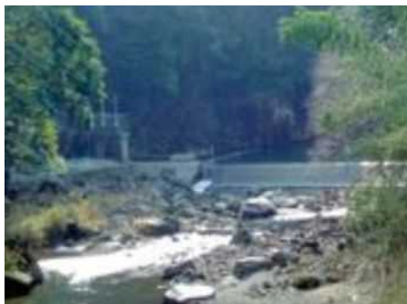
三重川取水堰
