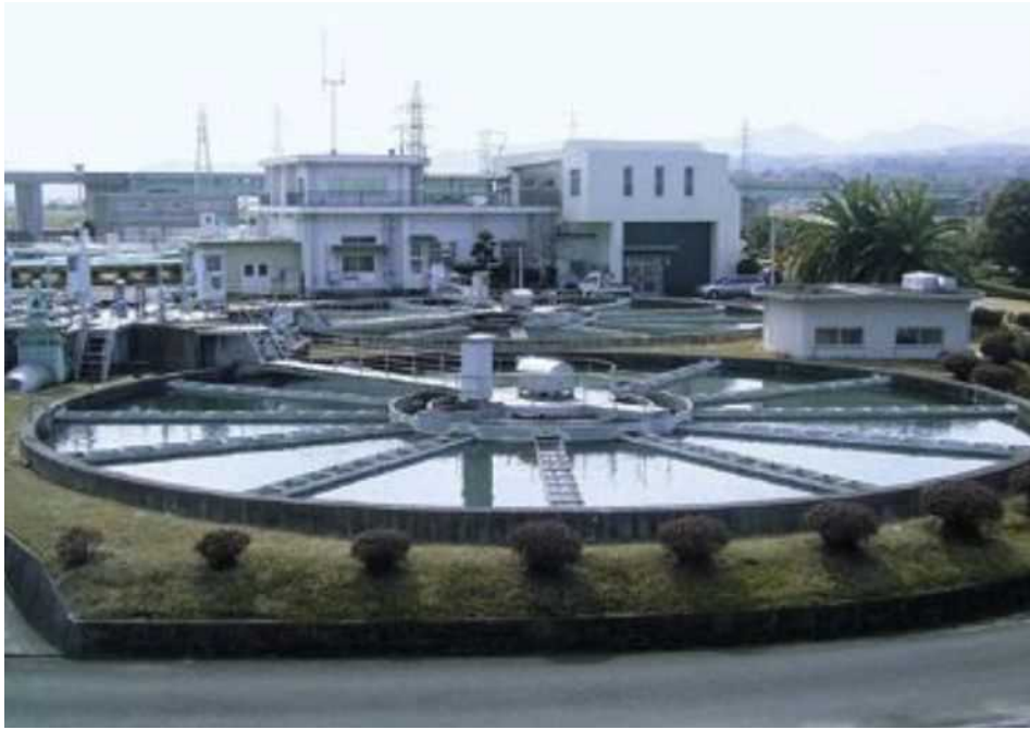
大津留浄水場（大分市）
