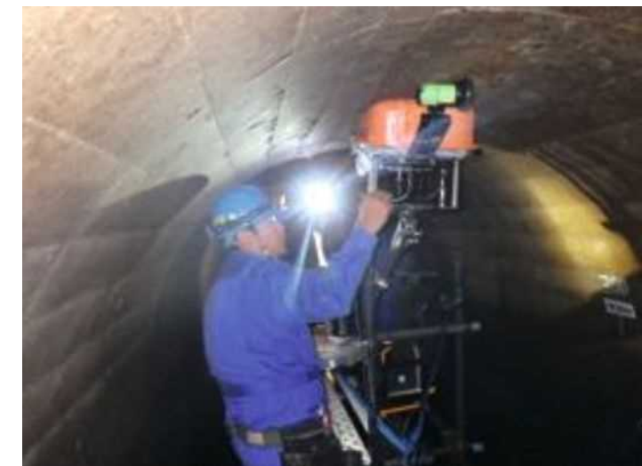
送水隧道点検中(火振志村線)
