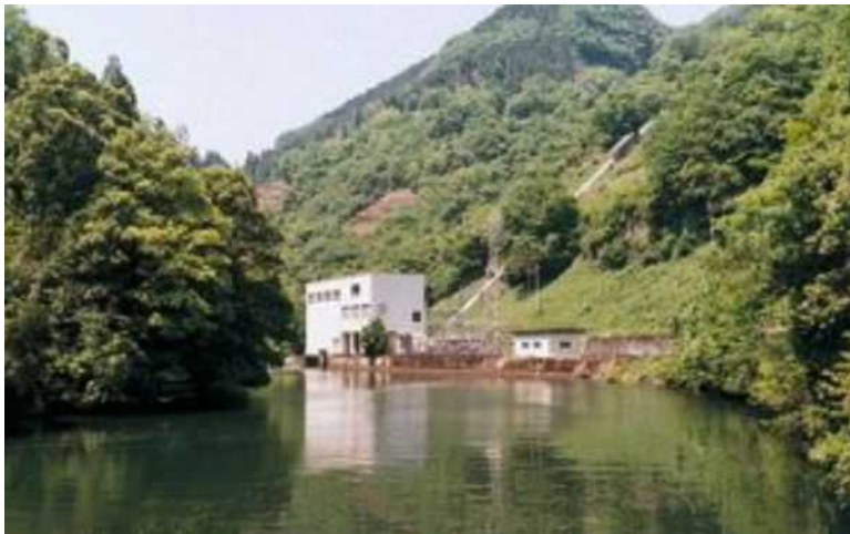
芹川第一発電所
