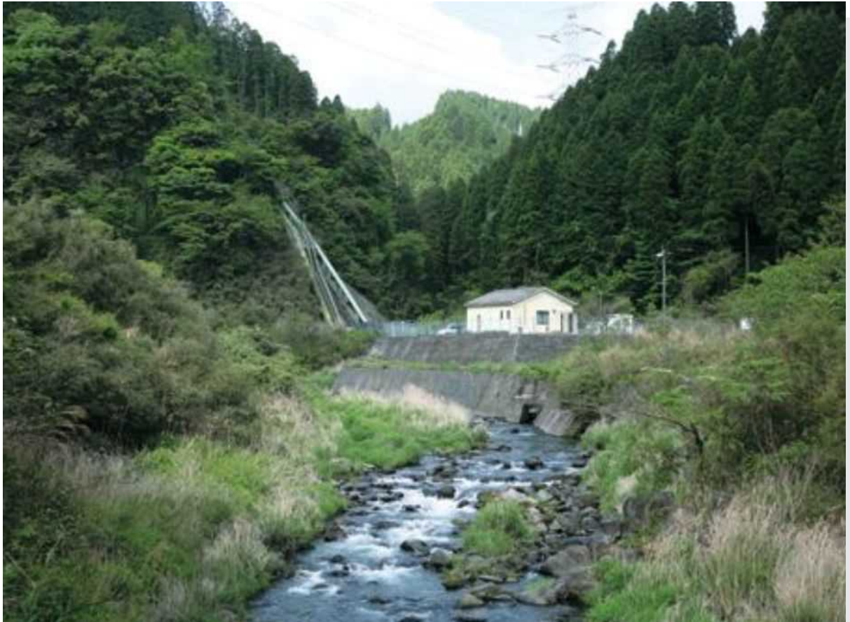
阿蘇野川発電所
