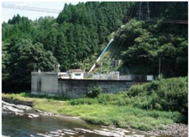
芹川第三発電所
