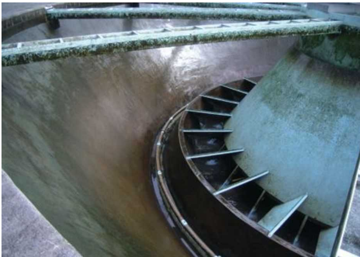
沈澱池清掃作業中
