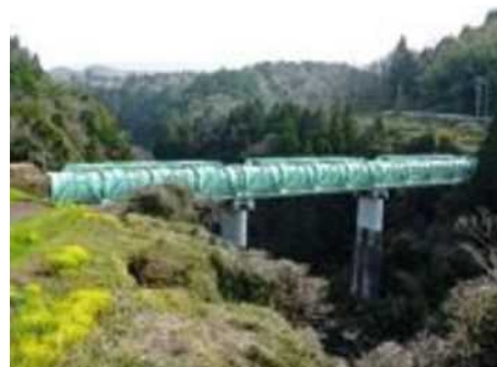
三重川水管橋
