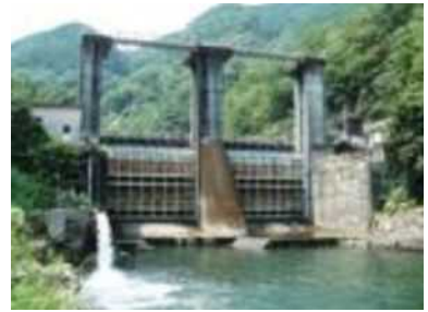
逆調整池ダム
