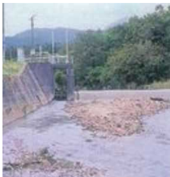
白水川取水堰
