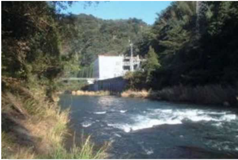
芹川第二発電所
