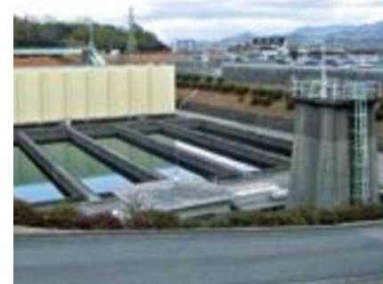
判田取水場 (中央が沈砂池)
