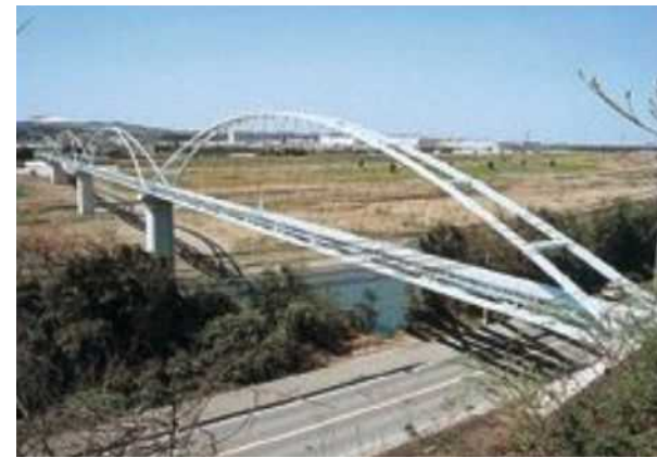
大野川松岡水管橋
