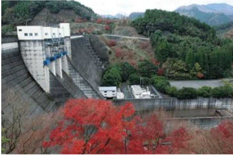
耶馬溪発電所
