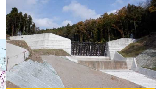
令和4年度の取組 砂防設備の整備
