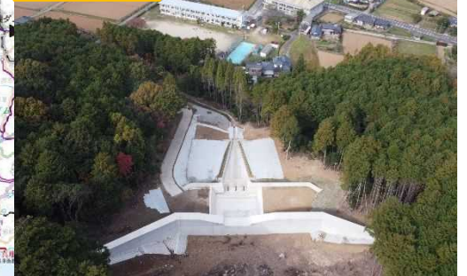
令和4年度の取組 砂防設備の整備
