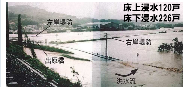
八坂川浸水写真(H9年9月)
