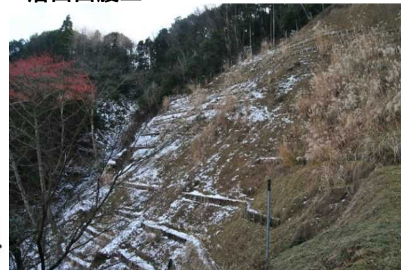
土砂を捕捉した治山ダム
