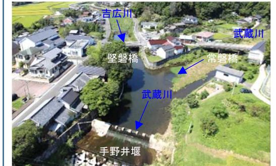
武蔵川(整備中状況写真)
