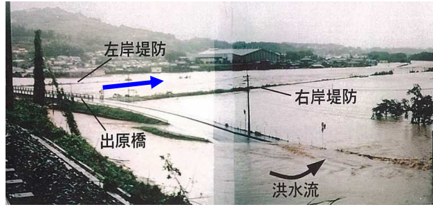
八坂川浸水写真(H9年9月)
