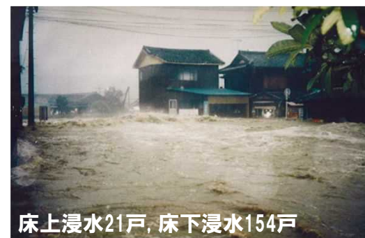
武蔵川浸水写真(H10年10月)
