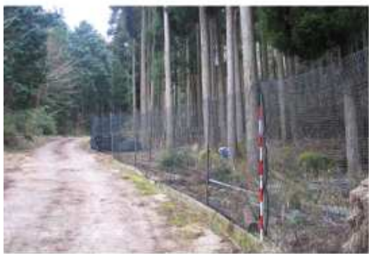
漁網を利用した防護柵(中津市)
