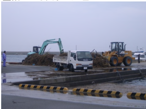
重機による回収・処理
