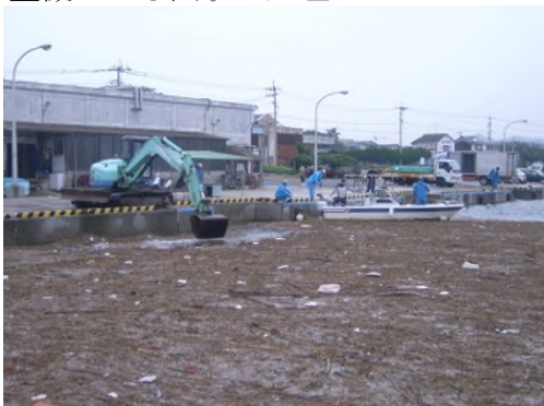
重機による回収・処理
