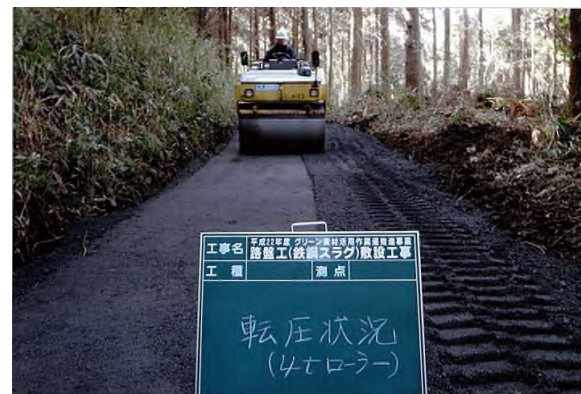
(鉄鋼スラグ敷設状況) ※転圧状況
