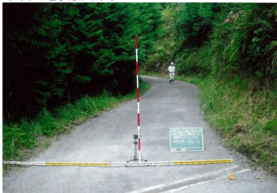
(鉄鋼スラグ路盤工:日田市) ※コンクリートのようになっている
