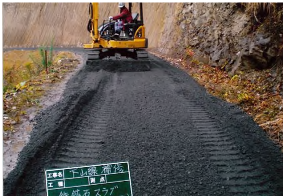
(鉄鋼スラグ敷設状況) ※敷均し状況
