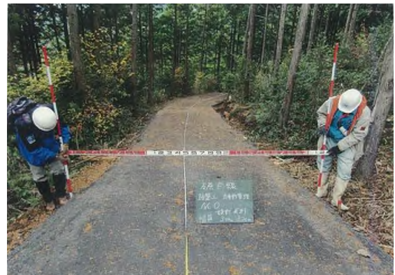
(鉄鋼スラグ路盤工:中津市) ※急勾配での施工
