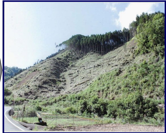
施工後（平成21年度）
