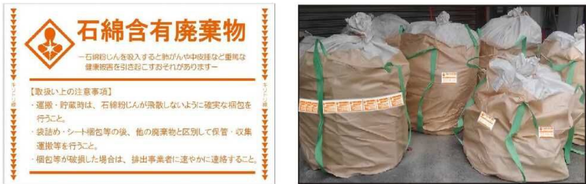
図3-7 石綿含有産業廃棄物の表示テープ
