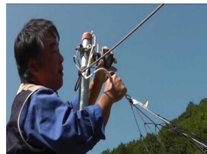
ネットの設置は電磁石でワンタッチ
