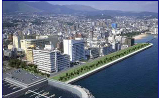
海岸環境整備事業による海岸整備 (別府港海岸北浜地区 大分県)
