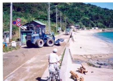
被災状況(佐賀関海岸)
